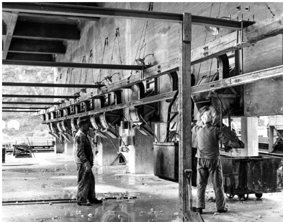
Produksjonen starta ved at vaggene på taubanen vart lasta med kol og kalkstein. Foto: Kraftmuseet sitt arkiv
