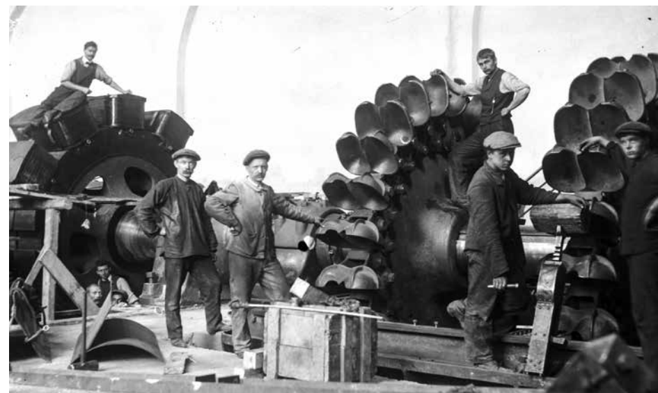
Montering av aggregat i Tyssedal kraftstasjon. Foto: Kraftmuseet sitt arkiv
