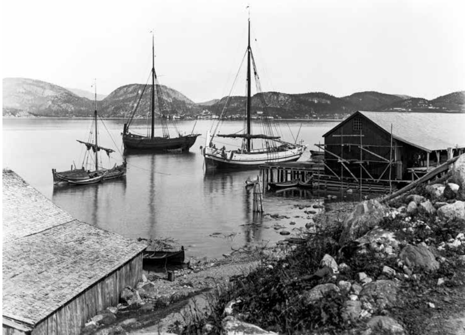
Jekter utenfor sagbrukets utskipningslager ca. 1890. Foto: Norsk Sagbruksmuseum
