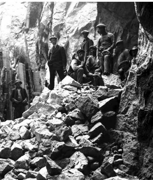
Arbeid med fordelingsbassenget på Lilletopp øvst i rørgata. Foto: Kraftmuseet sitt arkiv
