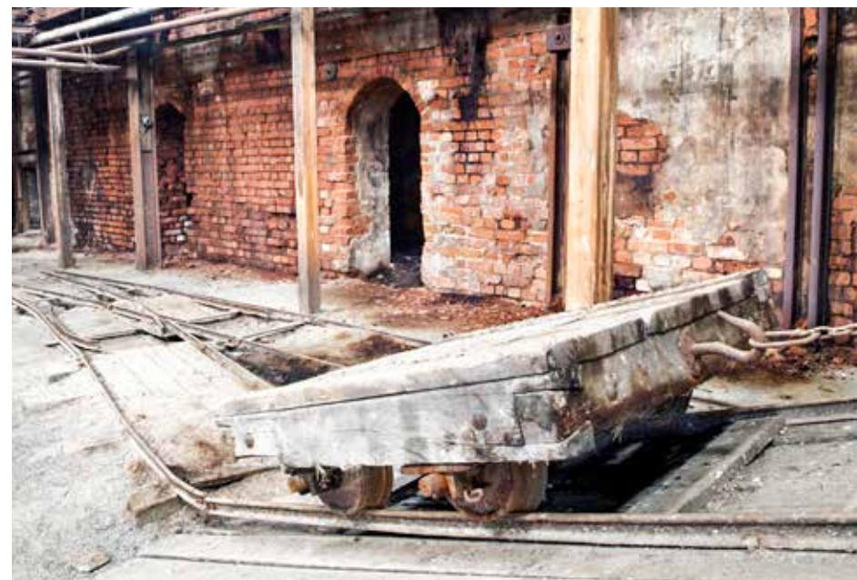
Interiør i Sodahuset. Vogna ble brukt til å frakte soda opp i smelta. Foto: Bård Løken
