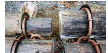
Dobbelt lense der stokkene bindes sammen med dobbeltredskap. Foto: Anke Loska, Riksantikvaren
