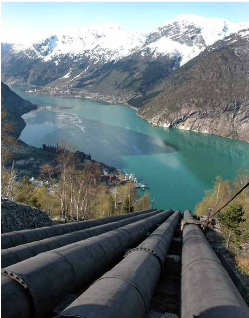
Den 730 meter lange rørgata stuper bratt ned frå fordelingsbassenget på Lilletopp til Kraftstasjonen ved Sørfjorden. Foto: Harald Hognerud, Kraftmuseet sitt arkiv
