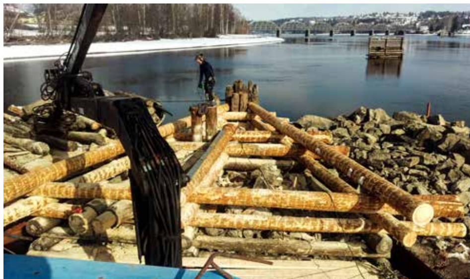
Vedlikehold av steinkarene i fløtingsanlegget i 2016. Foto: MiA Fetsund lenser
