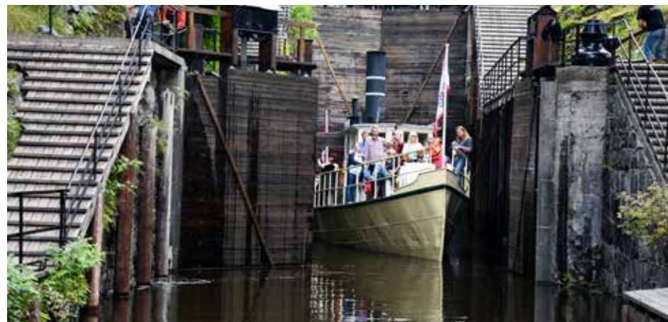
DS Engebret Soot i Ørje sluser. Foto: Steinar Fundingsrud
