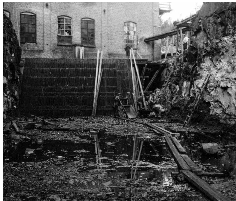
Utvidelse av varegrinda ved vanninntaket til tresliperiet i 1929. Foto: Kistefos
