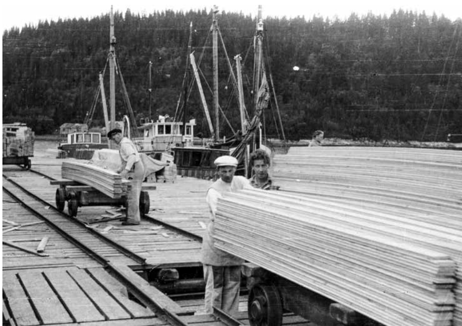
Utskiping av materialer Spillumbruket 1954. Foto: Norsk sagbruksmuseum
