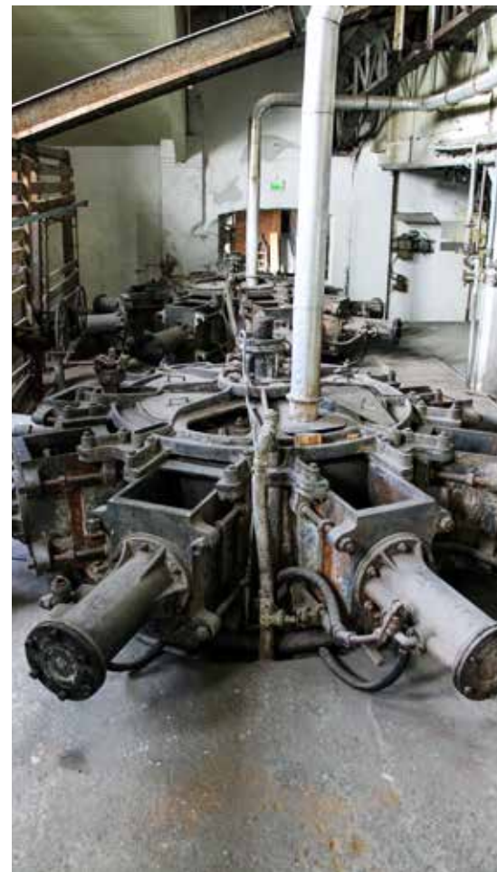
Horisontale slipemaskiner i tresliperiet. Foto: Kistefos
